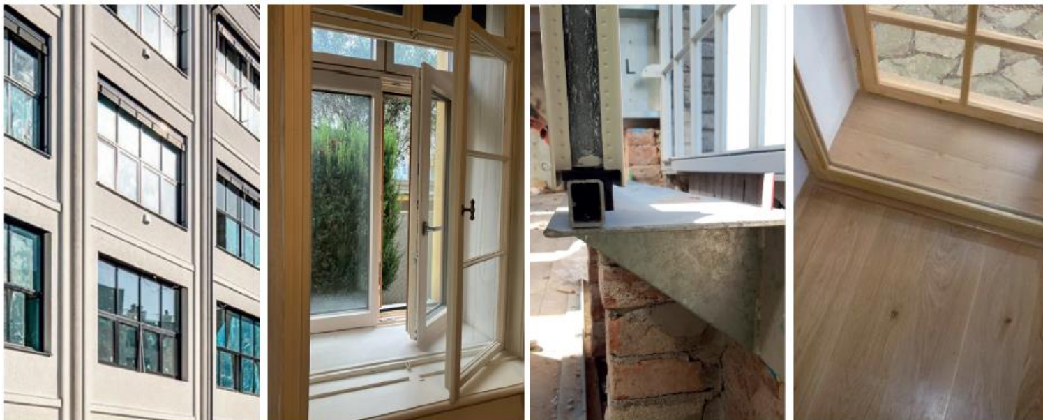
Obrázek 38: Příklad osazení oken v historických budovách – průmyslový areál; špaletové okno s vnitřním izolačním dvojsklem a vnější historickou replikou; umístění okna s trojsklem v rovině vnitřní tepelné izolace; vnitřní špaletové okno, vnější okno s trojsklem; foto: Karel Kladívko, Michal Čejka, Jan Klečka, Josef Smola
