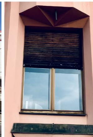
Obrázek 35: Příklad řešení vnějších stínících prvků na historických budovách; zdroj: Hiberatlas + foto: Michal Čejka
