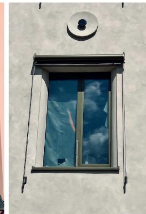
Obrázek 35: Příklad řešení vnějších stínících prvků na historických budovách; zdroj: Hiberatlas + foto: Michal Čejka
